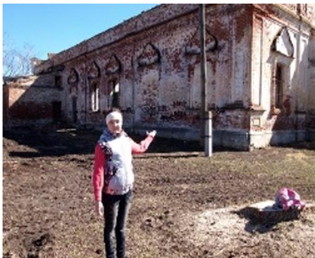
Мелитина Германова у разрушенной Сретенской церкви Ризоположенского монастыря
